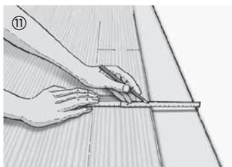
Für die letzte Reihe werden die Elemente an der Längsseite zugeschnitten und eingepasst. Auch hier ist der nötige Dehnungsabstand von 10–15 mm zu berücksichtigen.
