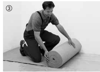
Zur Trittschalldämmung und zum Ausgleich kleiner Unebenheiten wird eine 2 mm dicke Korkdämmunterlage bündig ausgerollt. Alternative Dämmunterlagen finden Sie in unserem Zubehörangebot. Bitumenpappe eignet sich nicht zur Trittschalldämmung. Bei HARO Laminatboden mit Silent Pro® darf keine zusätzliche Dämmunterlage ausgelegt werden.
