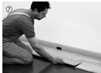
Mit dem Reststück der ersten Reihe wird in der nächsten Reihe wieder begonnen (stirnseitiger Versatz von mindestens 50 cm). Dadurch wird der Verschnitt erheblich reduziert. Die weitere Verlegung erfolgt elementweise. Dazu werden die Elemente zuerst längsseitig mit leichtem Druck in die Verbindung eingedreht.
