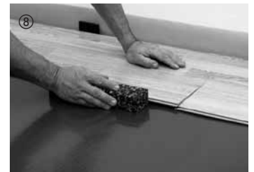
Bei Bedarf mit Schlagklotz leicht nachklopfen.
