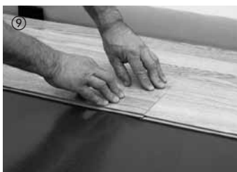
Anschließend wird das Element stirnseitig abgesenkt. Beachten Sie hierbei, dass das Element stirnseitig bündig an das zuvor verlegte Element anstoßt. Durch kurzen Druck auf den Querstoß rastet das Element ein.
