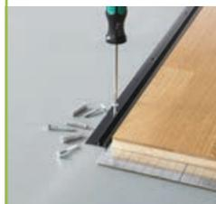
**1** Schneiden Sie das Basis- und Deckprofil an der gleichen Seite auf die benötigte Länge. Verschrauben Sie das Basisprofil auf dem Fußboden. Bei Fußbodenheizungen benutzen Sie bitte einen geeigneten Kleber.
