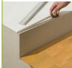
**1** Messen Sie die Länge der zu belegenden Treppenstufe und schneiden Sie das Basis- sowie das Deckprofil auf Maß. **Tipp:** Je nach Anwendung kann das Deckprofil von beiden Seiten gekürzt werden. So wird ein gleichmäßiges Lochbild auf dem Deckprofil erreicht.
