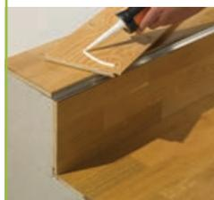
**4** Nach Überprüfung der Passgenauigkeit Ihrer Zuschnitte können Sie nun mit dem Verkleben oder Verschrauben des Basisprofils und der Treppenbeläge beginnen.
