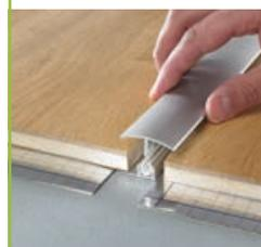
**3** Um das im Basisprofil gelagerte Kunststoffgelenk leicht zu spreizen, drücken Sie den Steg des Deckprofils in das Gelenk ein und klopfen Sie es mit der geballten Faust, bis das Deckprofil vollflächig auf beiden Bodenbelägen aufliegt.
