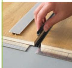
**3** Legen Sie jetzt das U-förmige Erhöhungsprofil in das Basisprofil ein.
