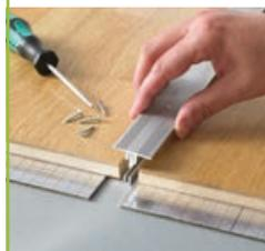
**3** Legen Sie die Stege des Deckprofils über das Basisprofil.
