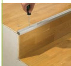
**5** Setzen Sie das Deckprofil mit dem Steg in die Nut des Basisprofils ein und verschrauben Sie es mit den beiliegenden – farblich passenden – Senkkopfschrauben.
