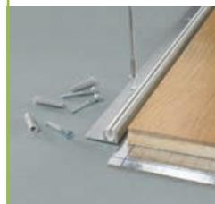
**1** Schneiden Sie das Basis- und Deckprofil an der gleichen Seite auf die benötigte Länge. Verschrauben oder verkleben Sie das Basisprofil auf dem Fußboden. Bei Fußbodenheizungen benutzen Sie bitte einen geeigneten Kleber.
