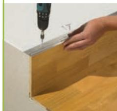
**3** Positionieren Sie das Basisprofil auf der Trittstufe und messen Sie die zu belegende Tritt- und Setzstufe aus. Übertragen Sie die Maße auf Ihren Belag und schneiden Sie die Tritt- und Setzstufe mithilfe einer Tischkreissäge oder Stichsäge zu.
